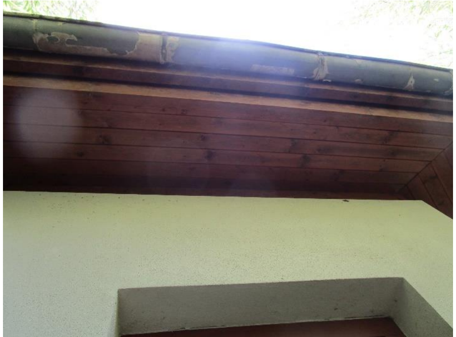
Foto 6: Dachvorsprung am Badegebäude (mit Nische)
