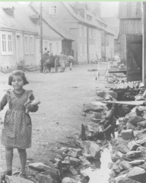
Abwasserrinne am Straßenrand, frühes 20. Jhd.
