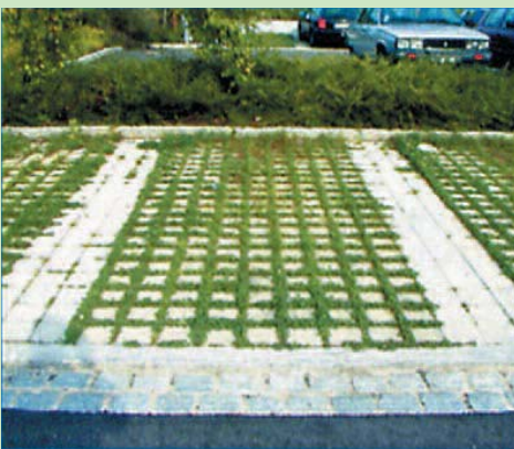
Die Verwendung von Rasengittersteinen anstelle von Asphalt macht das Versickern von Niederschlägen möglich
