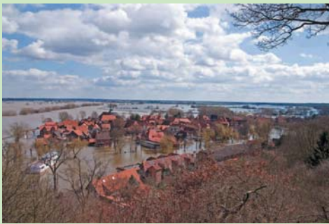
Überflutungsgebiet in Hitzacker (Niedersachsen) beim Elbehochwasser 2006
