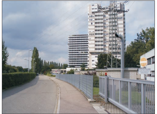
Wohngebäude nördlich der B 36
