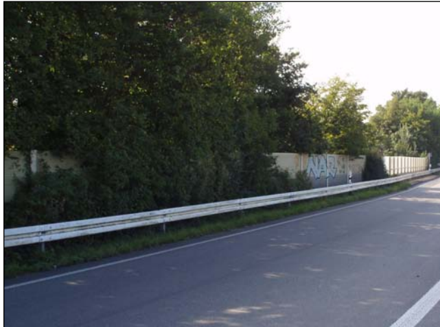
Lärmschutzwand an der B 3 in Lahr
