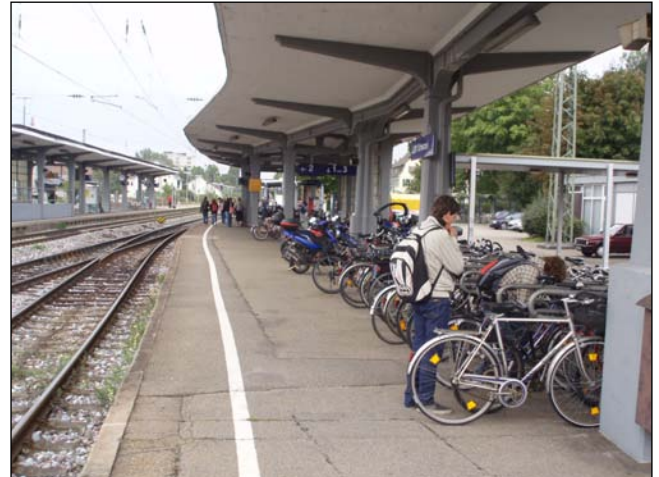
Radabstellanlage am Bahnhof Lahr
