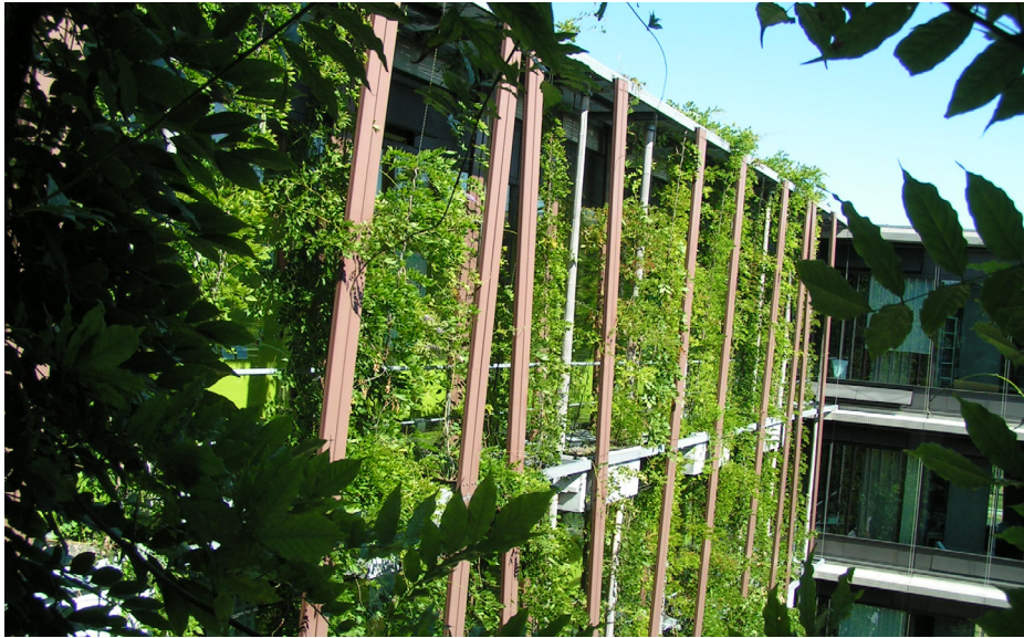
Die Fassadenbegrünung am Institut für Physik der HU Berlin kühlt bei Hitze. (Foto: Marco Schmidt)
