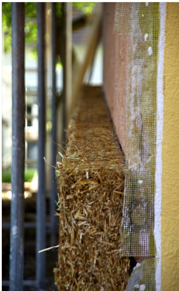
Gebäudedämmung mit Strohdämmplatten (Foto: maxit)
