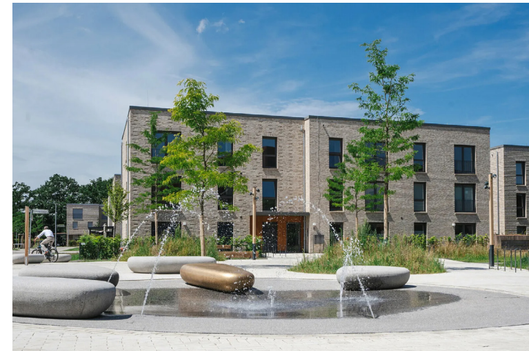
Klimaangepasstes Neubaubereich Herzkamp in Hannover (Foto: Gundlach Bau & Immobilien)
