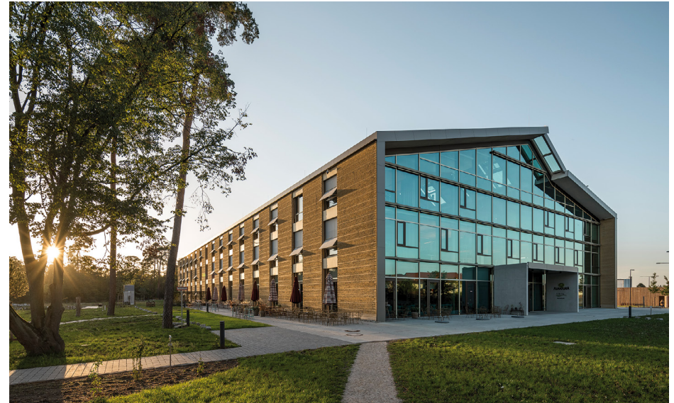
Der Alnatura Campus in Darmstadt ist europaweit das größte Bürogebäude, dessen Außenfassaden aus Lehm gebaut sind (Quelle: Alnatura, Foto: Lars Gruber)
