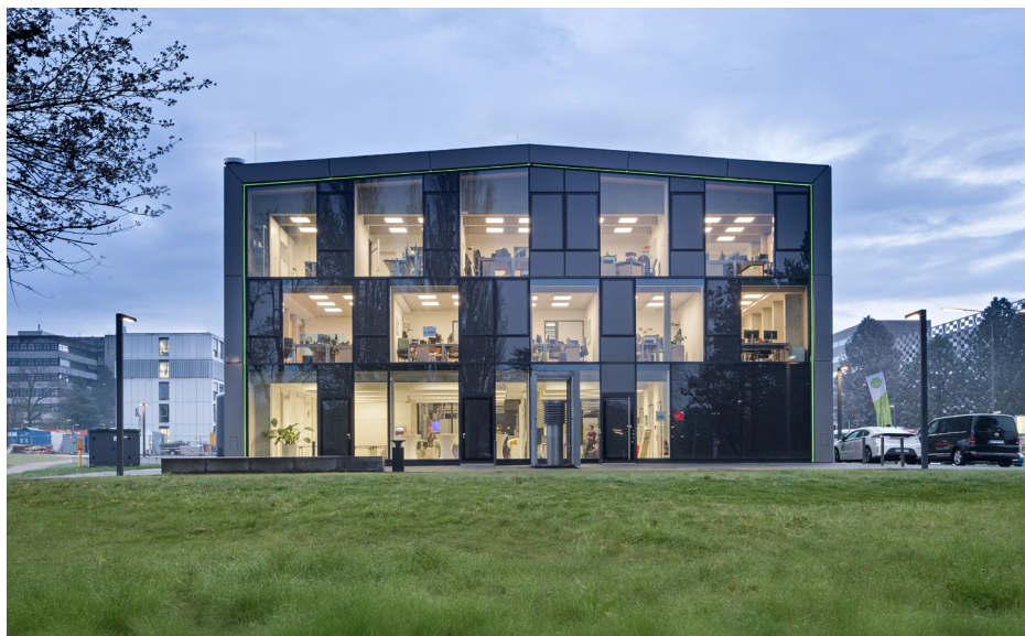
Die ETA-Fabrik auf dem Campus Lichtwiese der TU Darmstadt mit zukunftsweisender Bautechnik (Foto: TU Darmstadt, bildhubsche fotografie – Andreas Koerner)
