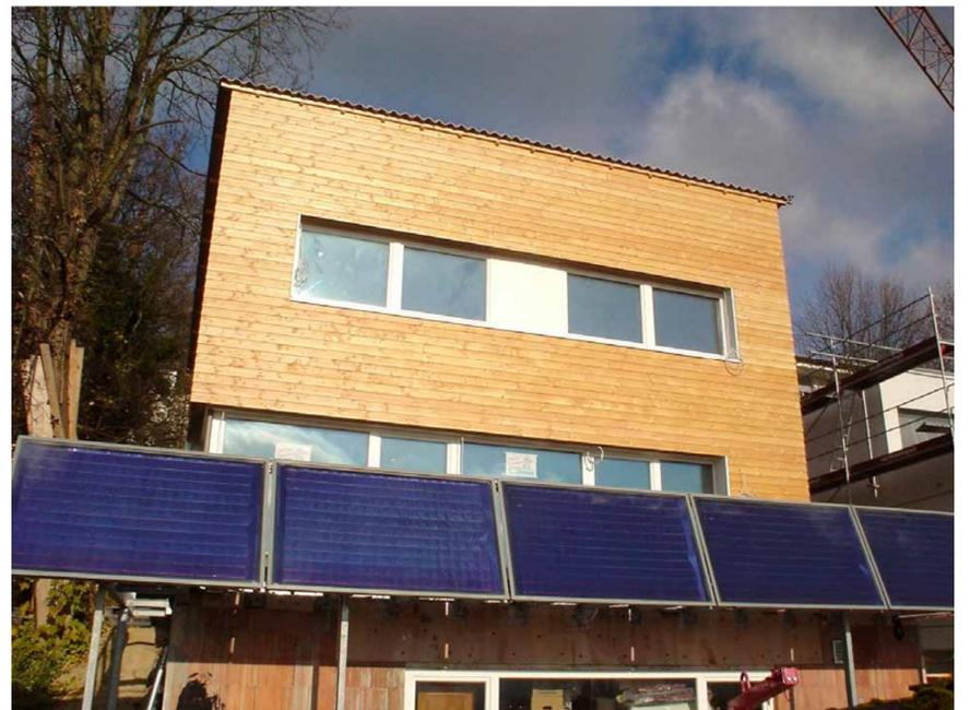
13 m<sup>2</sup> Sonnenkollektoranlage für Heizung und Warmwasser. Wärmepumpe und Solaranlage werden zurzeit messtechnisch erfasst.
