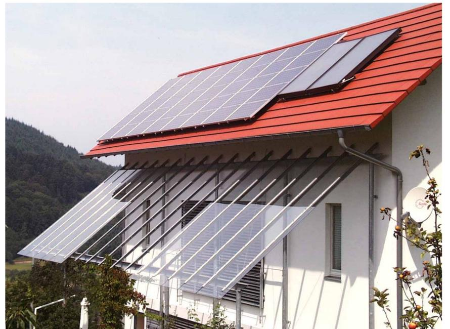
Module rechts: 5 m<sup>2</sup>-Sonnenkollektoranlage zur Warmwassererzeugung, jährlicher solarer Deckungsanteil: 65%
