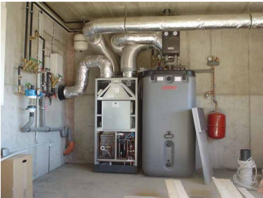
480 Watt Klein-Wärmepumpe und Lüftungsanlage mit Wärmerückgewinnung (links, geöffnet) und 500 Liter-Solarwärmespeicher
