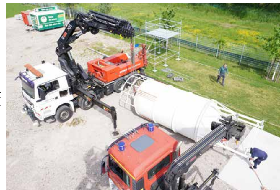
Aufbau des Silos an der Feuerwache West
