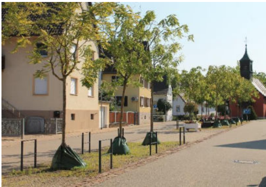
Abbildung 49: Neugestaltete Wylert Hauptstraße (Quelle: WHS, 2021)
