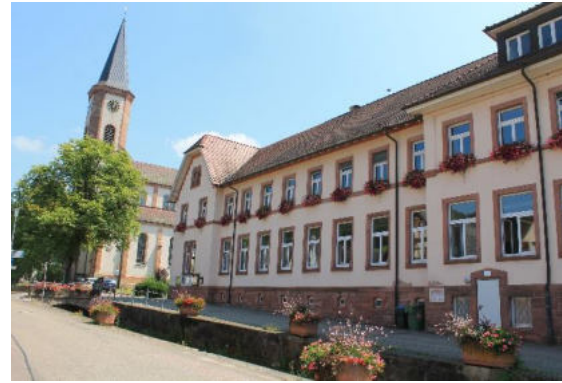
Abbildung 70: Grundschule Reichenbach (Quelle: WHS, 2021)
