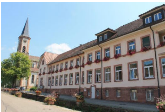
Abbildung 22: Grundschule Reichenbach (Quelle: WHS, 2021)
