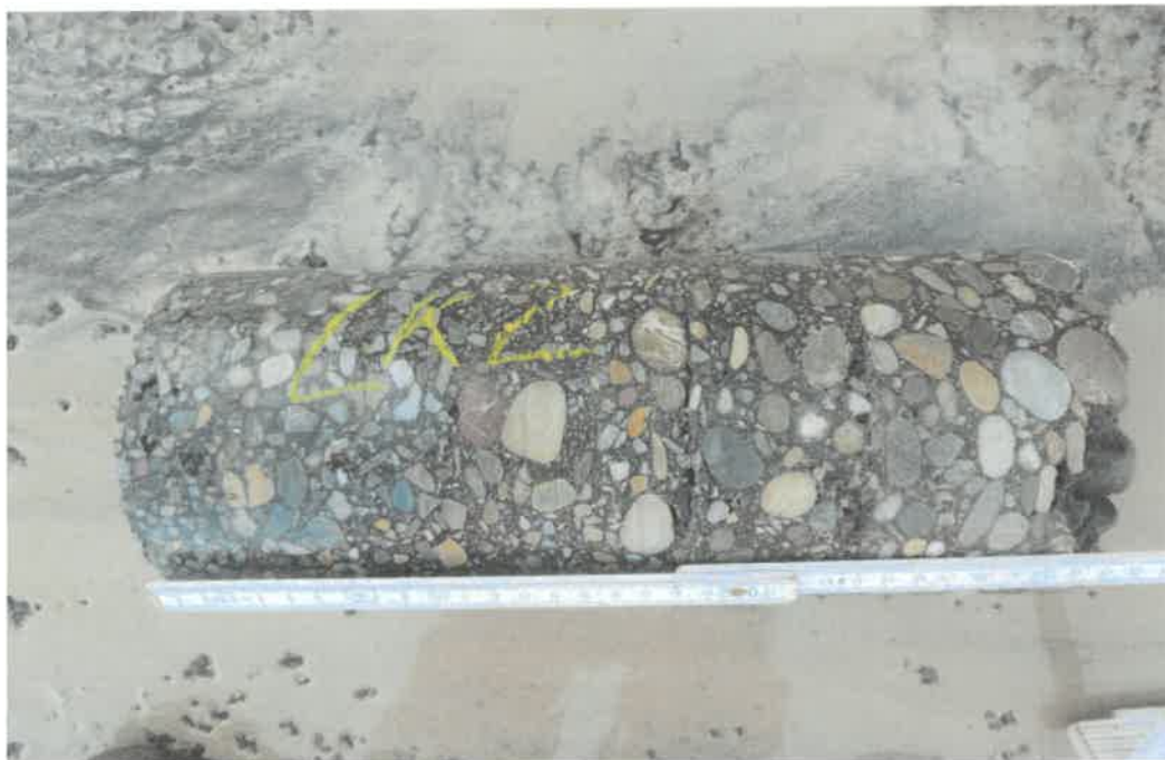
Bild 6: Bohrkern "LK-2" nach der Entnahme
