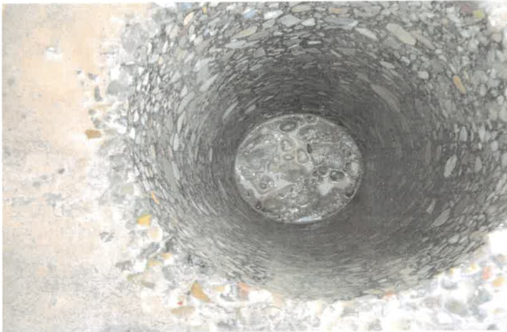
Bild 7: Blick in das Bohrloch von Bohrkern "LK-2"
