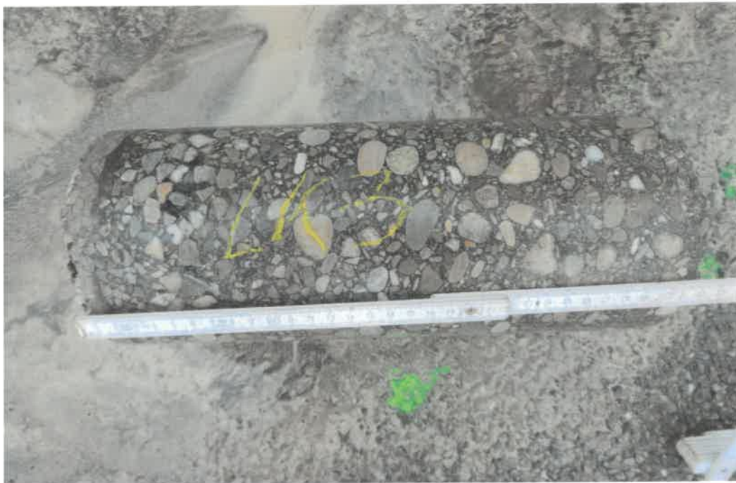
Bild 11: Bohrkern "LK-3" nach der Entnahme
