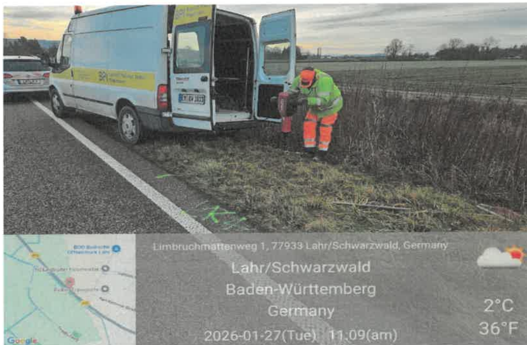
Bild 15: Entnahmestelle von Bohrkern "KF-4 "
