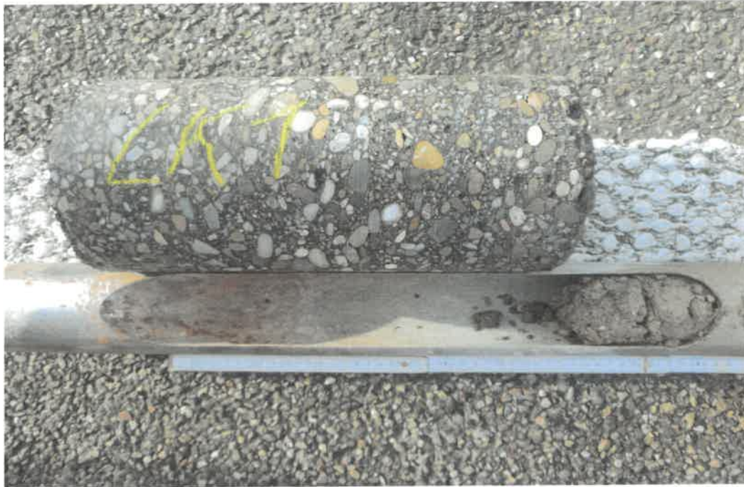
Bild 3: Kleinbohrung bei LK-1 von 0,00 bis 0,30 m Tiefe
