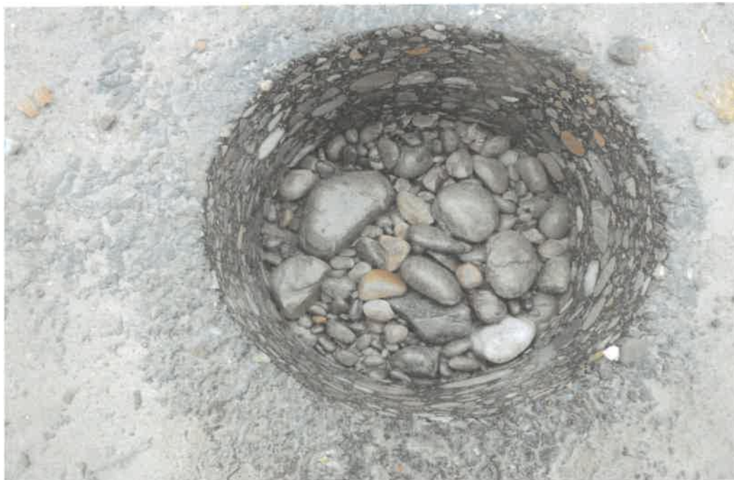
Bild 30: Bohrkern "LK-7" nach der Entnahme
