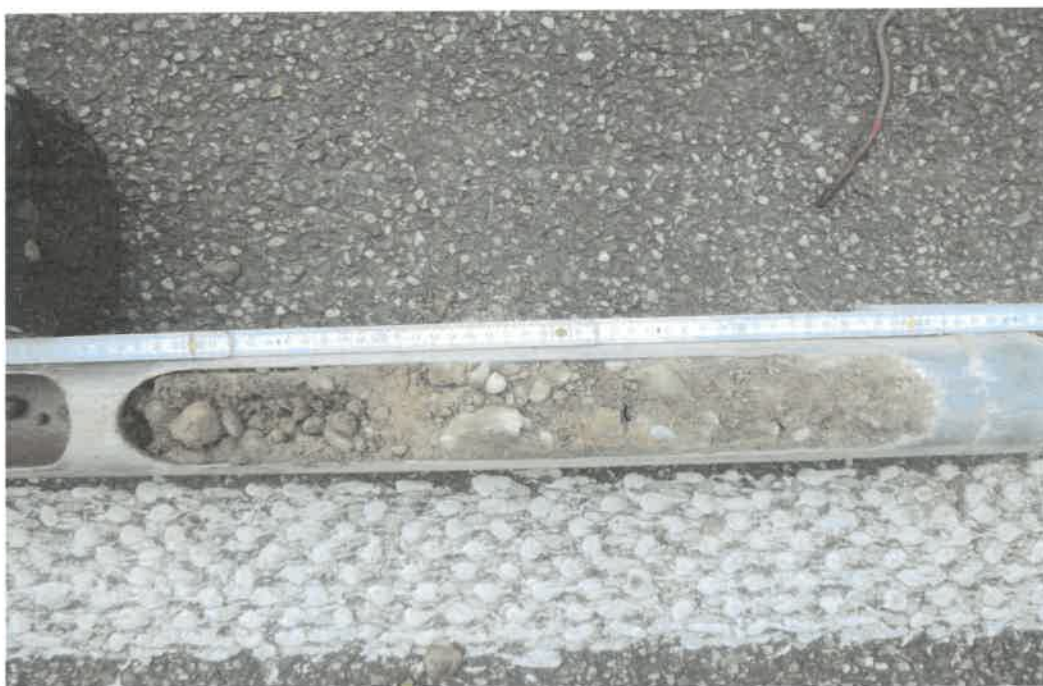
Bild 14: Kleinbohrung bei LK-3 von 0,4 bis 1,00 m Tiefe
