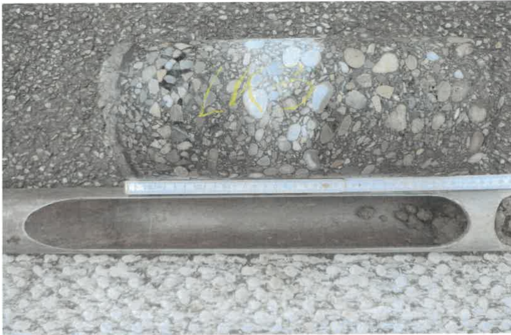
Bild 13: Kleinbohrung bei LK-3 von 0,0 bis 0,40 m Tiefe
