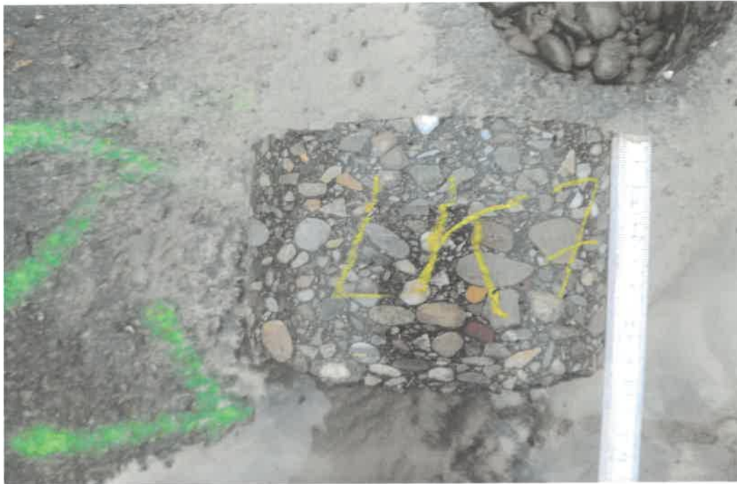
Bild 29: Bohrkern "LK-7" nach der Entnahme
