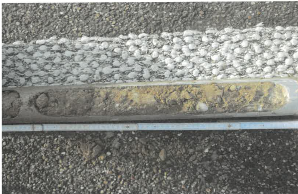
Bild 4: Kleinbohrung bei LK-1 von 0,30 bis 1,00 m Tiefe
