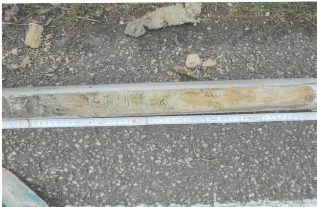
Bild 22: Kleinbohrung bei LK-5 von 1,2 bis 1,80 m Tiefe
