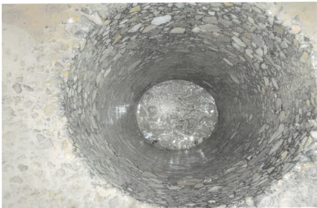
Bild 12: Blick in das Bohrloch von Bohrkern "LK-3"
