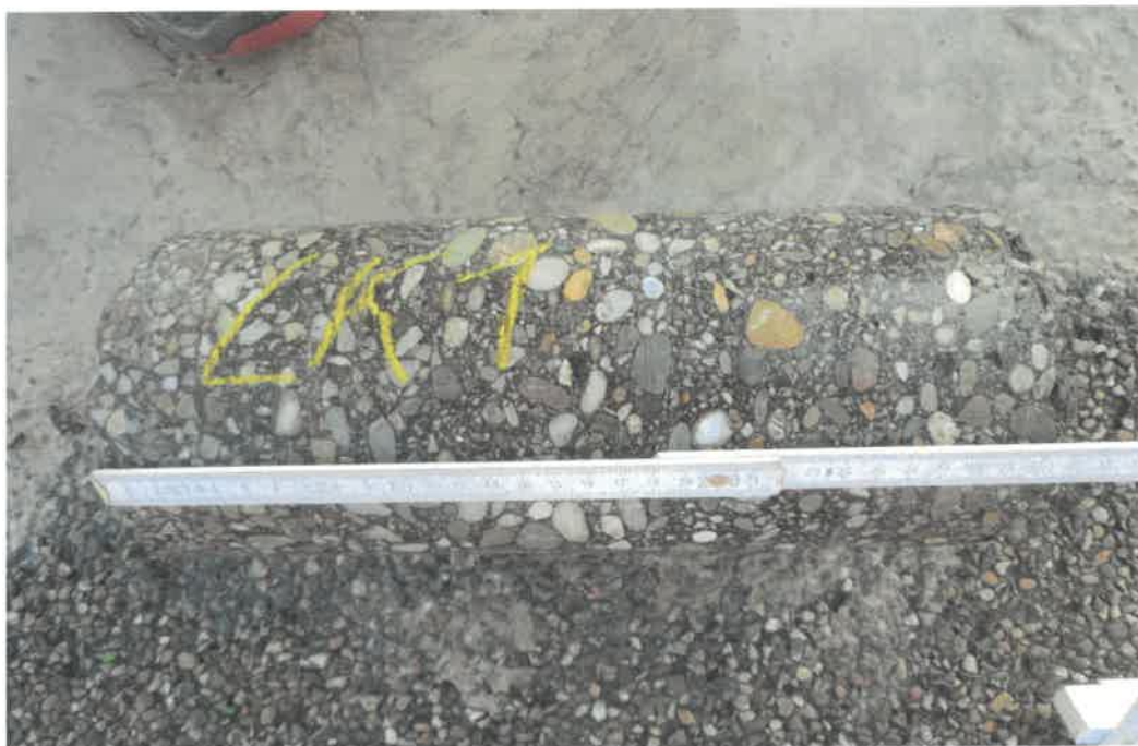
Bild 2: Betonbohrkern "LK- 1" nach der Entnahme
