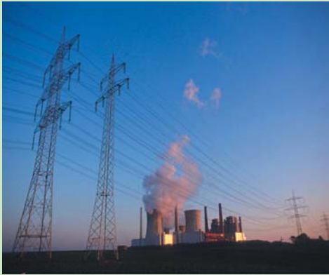
Vom Kraftwerk aus über Hochspannungsleitungen ...
